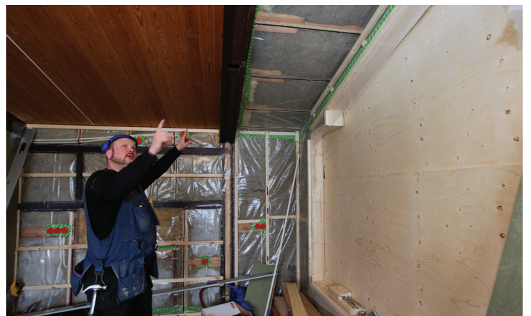
Búið er að lengja húsin á Einarstöðum. Oddur Logi Reynisson, smiður hjá Eini, bendir á sperruna sem áður markaði útenda hússins.
